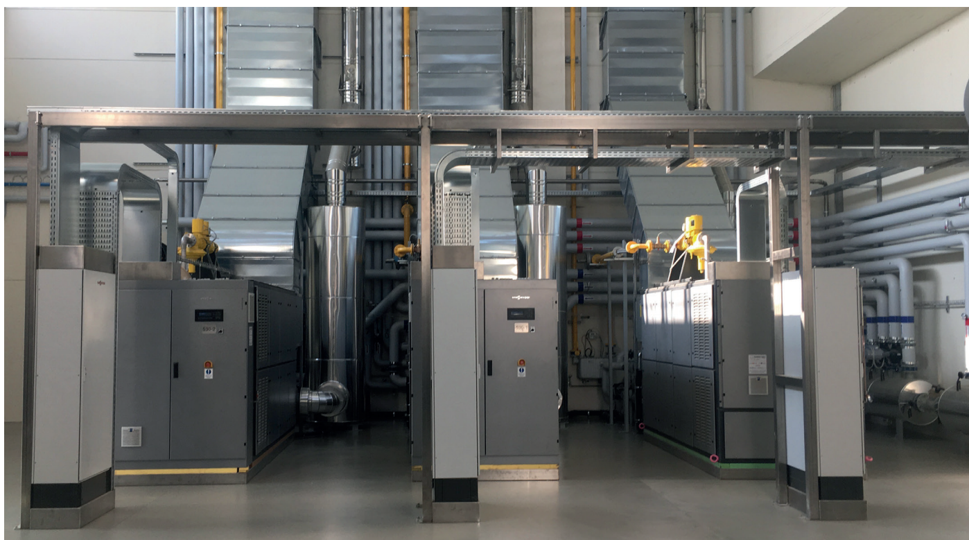
Installazione di tre cogeneratori Vitobloc presso Gai, macchine imbottigliatrici - Cuneo
